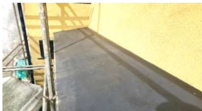
高压洗浄後 研磨
