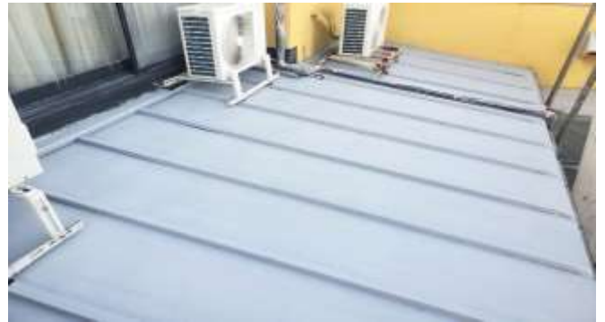
下地処理 錆止め
