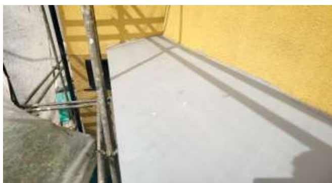
下地処理 錆止め
