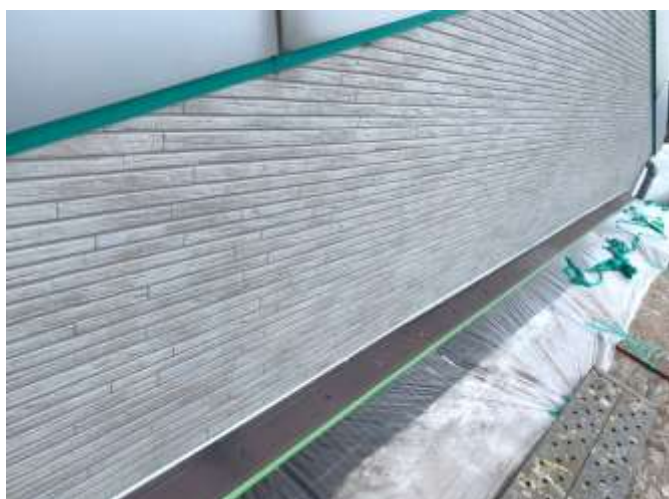
高圧洗浄後 養生
