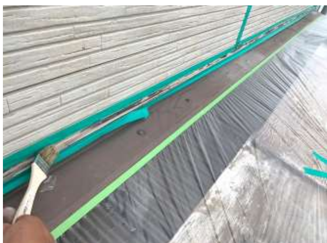
養生後 プライマー
