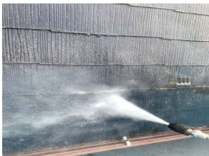
屋根 高压洗净
