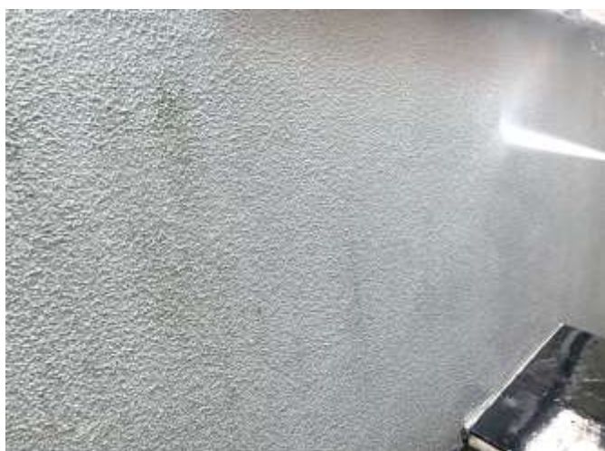
外壁 高压洗净
