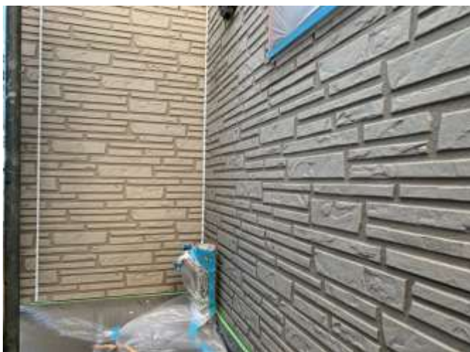
高圧洗浄後 施工前
