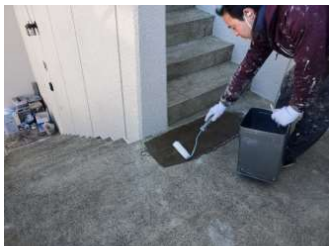
高压洗净後 撥水剤塗布 一回目
