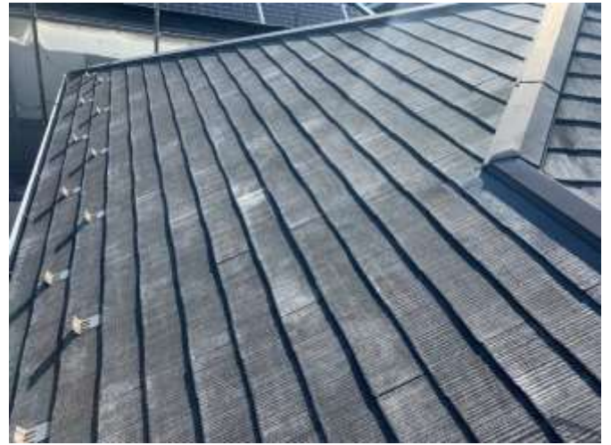
高圧洗浄後 施工前
