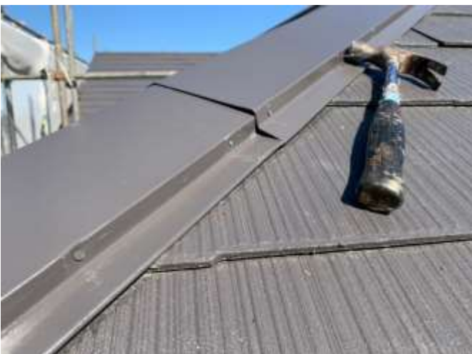
下地処理 トタン釘打ち増し 完了
