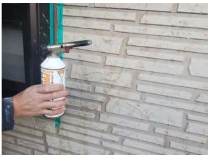
下地処理 ツタ撤去
