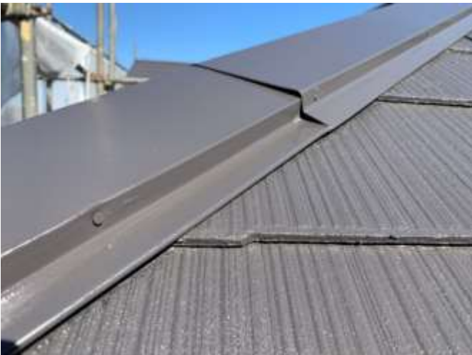
下地処理 トタン釘打ち増し 前
