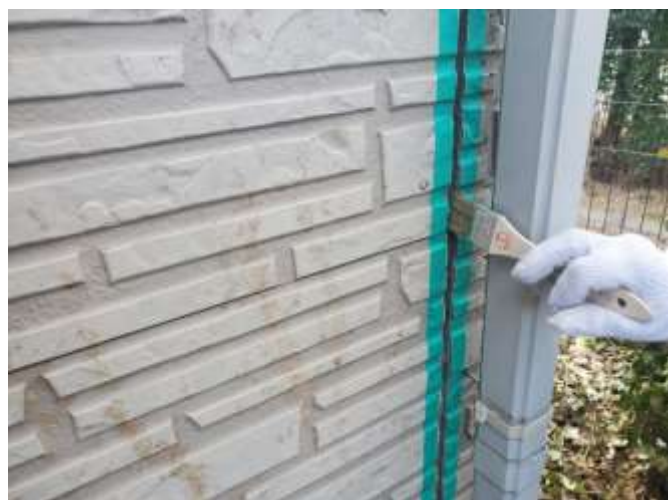
プライマー塗布
