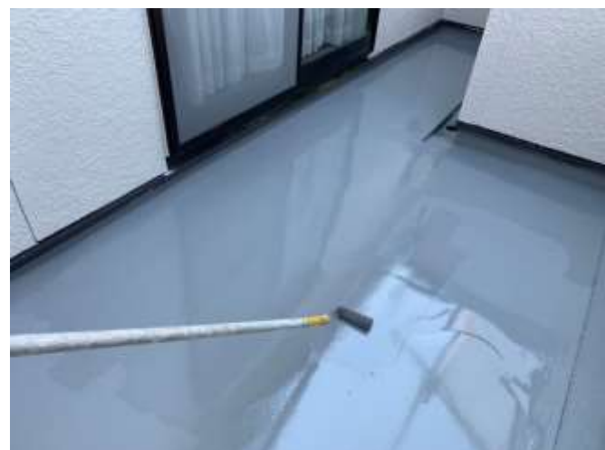
防水保護剤 上塗り／完了
