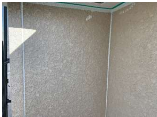
高圧洗浄後 施工前
