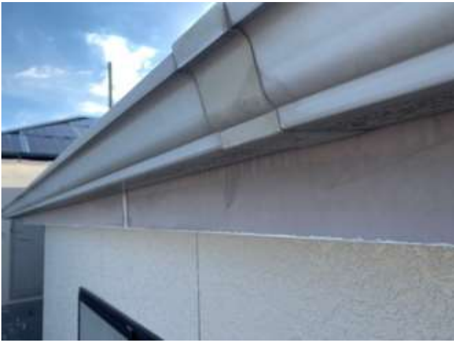
高圧洗浄後 施工前
