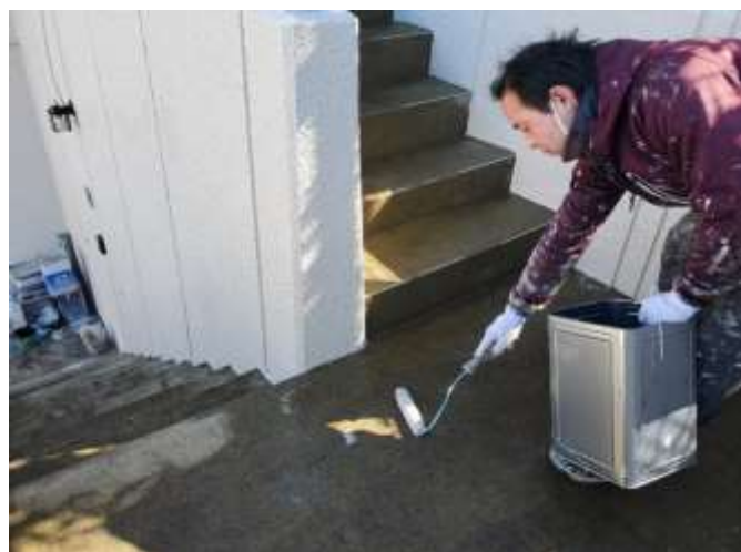
撥水剤塗布二度・三度塗り 完了
