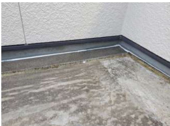
下地処理 ひび割れシール打ち
