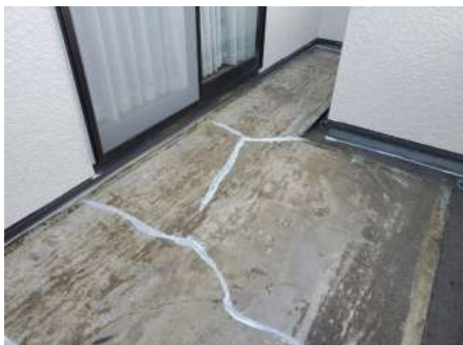
下地処理 ひび割れシール打ち
