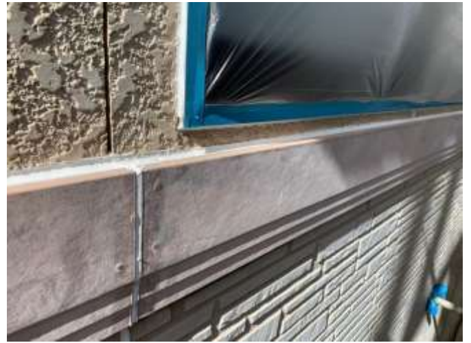
高圧洗浄後 施工前
